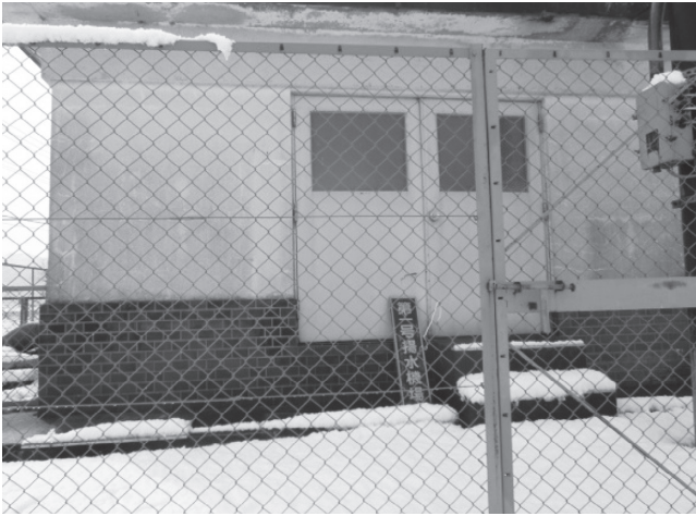
第9図. 新田井堰土地改良区揚水機1号機 撮影：執筆者（2013年2月22日）
